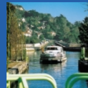
Pont canal à Agen
